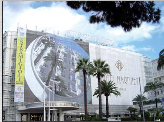
▲ Bâche tendue sur façade Hôtel Martinez (Cannes)
